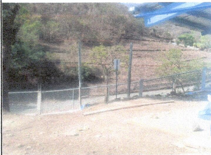
Foto 1: Mejoramiento del Cerco o muro Perimetral
