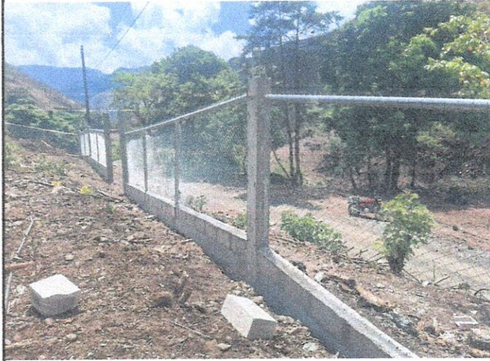
Foto 2: Mejoramiento del Cerco o muro Perimetral
